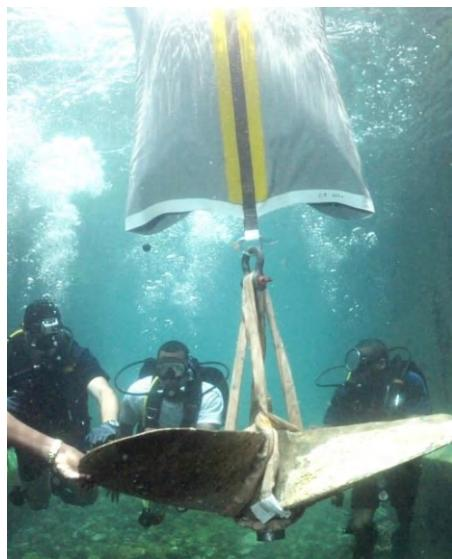
Wenn du deine eigenen Hebesäcke machen möchtest, kannst du dieses aus den Innenschläuchen von Autos, Traktoren oder LKWs anfertigen. Solche Schläuche gibt es in verschiedenen Größen. Du musst nur an einer Stelle ein Loch schneiden und ein Seil durch den ganzen Schlauch ziehen. Danach befestigst du beide Seilenden mit einem Karabiner oder einem Ring.
